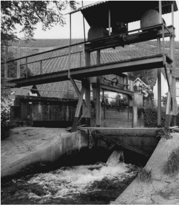
Die Stellfalle (Einlaßschleuse) des Mühlbachs an der Acher, direkt oberhalb der Dichtmühle
